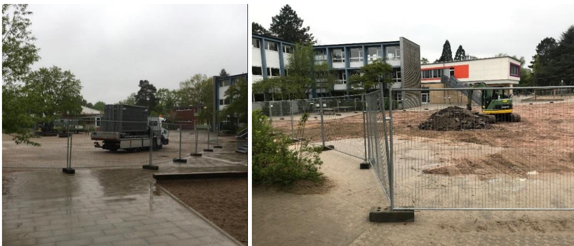
Impressionen vom Einrichten der Baustelle und Entfernen der Asphaltdecke
